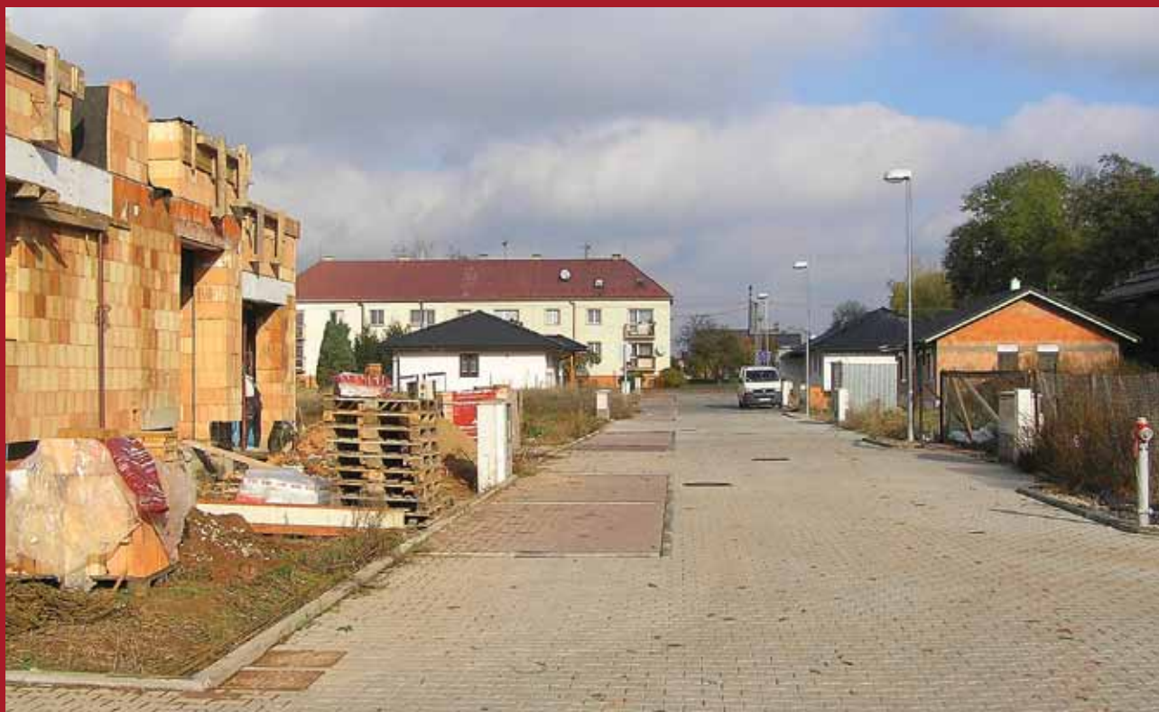
U tzv. starého Sídliště byl vybudován základ nové ulice s připravenými inženýrskými sítěmi, která byla pojmenována K Zahrádkám, a již se zde zaplňují parcely novými domky.
