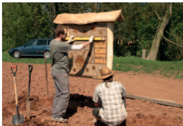
Plivátka jsou znovu v kurzu. Instalace budoucí informační cedule se současným plně funkčním hmyzím hotelem.
