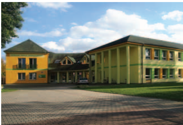
Budova Střední školy potravinářské Smiřice
