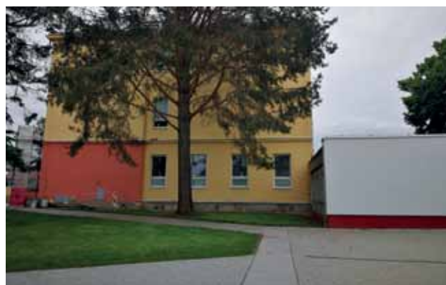
Severní strana školní budovy s opravenou fasádou
