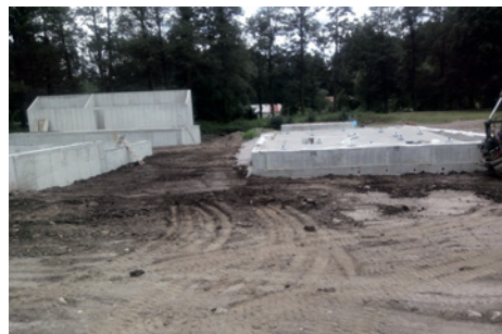
Terénní úpravy kolem bazénů
