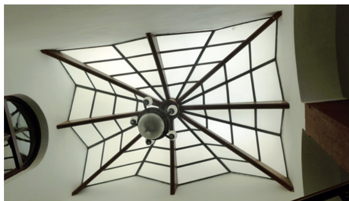
Ale i z obyčejného světlíku dokáže udělat šikovný architekt zajímavé dílko, jako je tomu na radnici.
