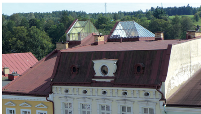
Skleníkovitě vystupující světlíky člení hřebenovitou střechu řady z domů na náměstí.
