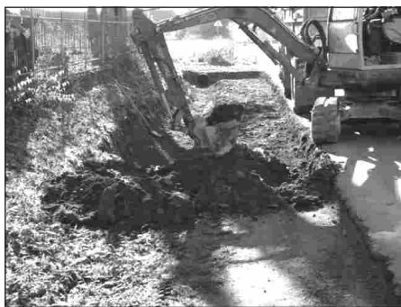
Práce na novém chodníku před ZŠ
