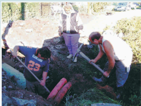
Rozšíření rozvodů kabelové televize
