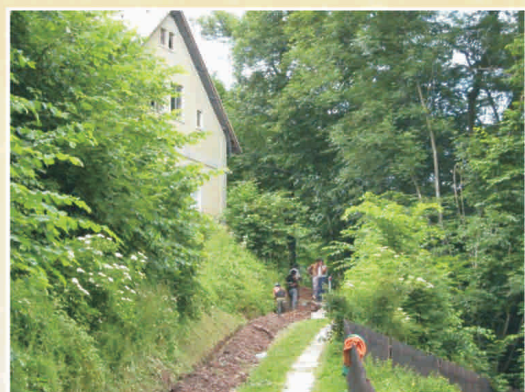
Rozšíření kabelové televize - výkopové práce
