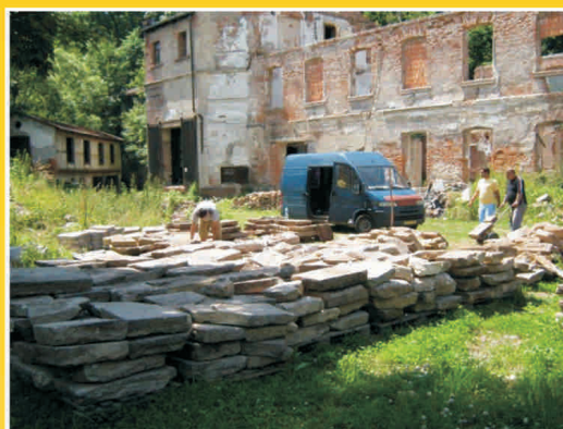
Demolice skladu u školní jídelny Prostřední Lánov - rozebírání stavebních prvků
