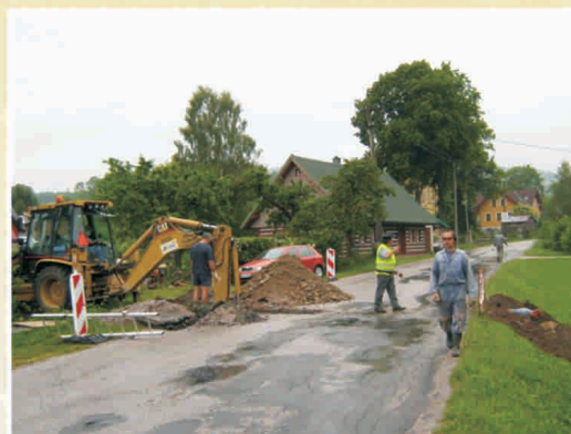
Překopy komunikace v Horním Lánově pro KTV a kanalizaci v rámci rekonstrukce silnice Lánov - Vrchlabí přes Strážné
