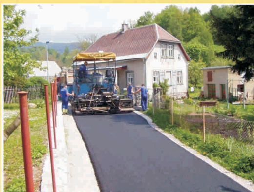
Rekonstrukce místní komunikace v Lánově
