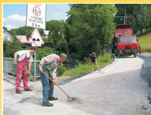
Penetrace místní komunikace za hospodou v Horním Lánově
