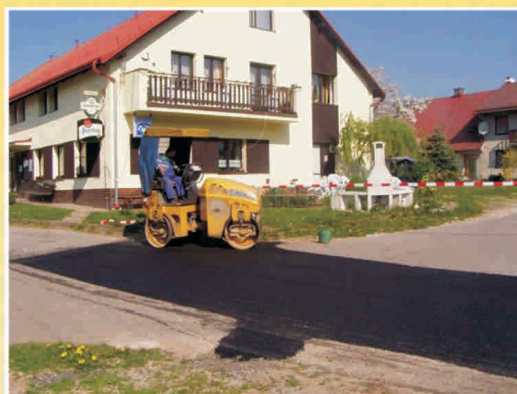
Rekonstrukce místní komunikace v Lánově
