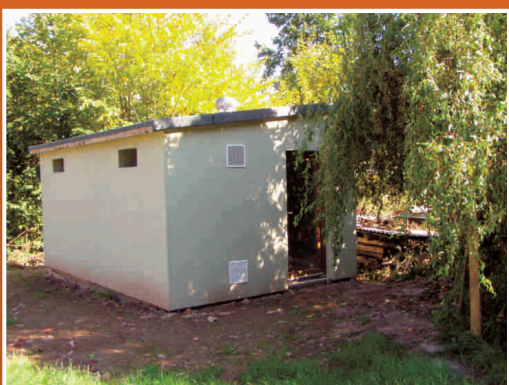
Zrekonstruovaná čistírna odpadních vod u jídelny.
