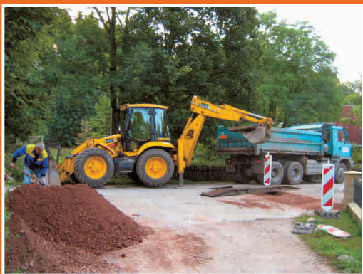
Rekonstrukce silnice Vrchlabí - Strážné - Lánov.
