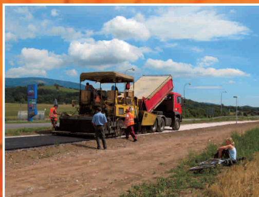
Cyklostezka etapa B, dokončovací práce.
