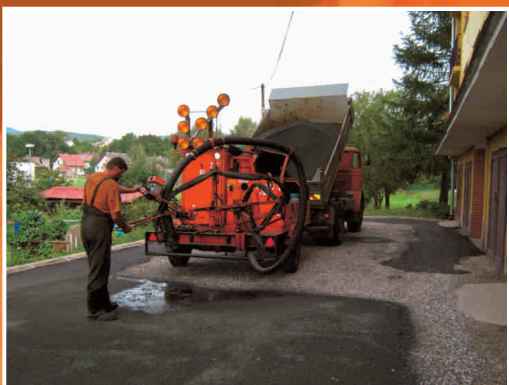
Údržba stávajících místních bezprašných komunikací - penetrace.
