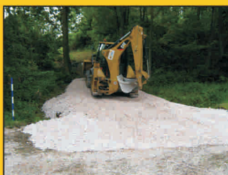
Práce na spojovací cestě za penzionem Baron.
