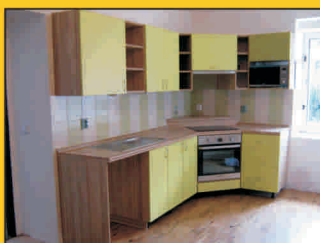
Dokončený obecní byt v čp. 63.
