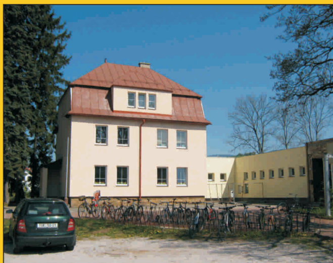
Dokončení zateplení, výměny oken a fasády u ZŠ Lánov.
