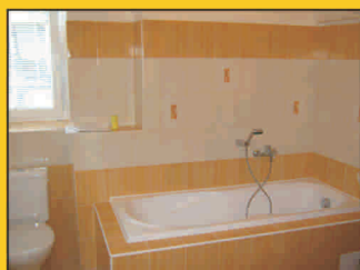
Dokončený obecní byt v čp. 63.
