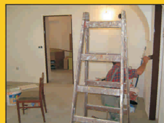
Dokončovací práce v obecním bytě čp. 63.
