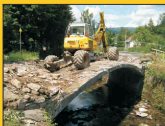
Demoliční práce na silničním mostě v Horním Lánově přes Malé Labe.
