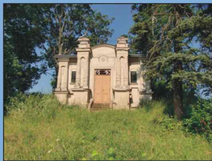
Vodárna v Dolním Lánově - čelní pohled.
