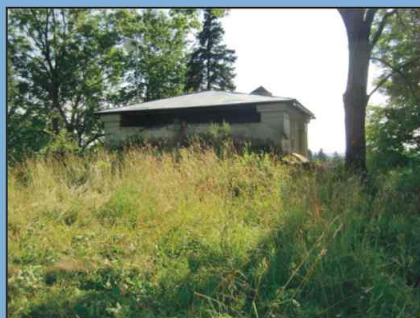
Vodárna v Dolním Lánově - pohled zezadu.
