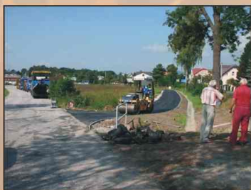
Dokončování cyklostezky směr na Trutnov.
