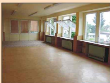
Třída MŠ před rekonstrukcí.
