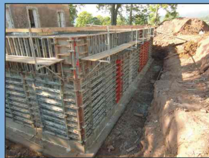
Vodárna v Dolním Lánově - stavební práce.
