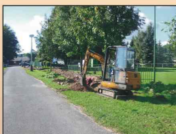
Práce pro kabel O.
