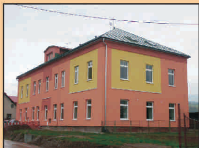
ZŠ „B“ po ukončení prací na zateplení.
