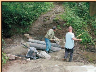
Práce na přechodu přes potok za Oázou.
