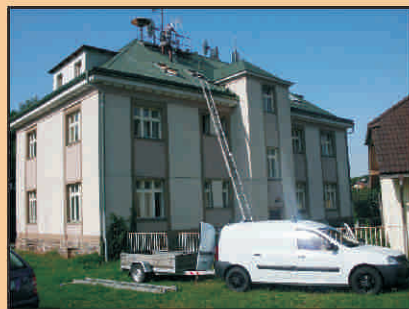
Zateplení ZŠ - budova „B“.
