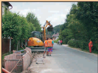
Pokračující práce na kanalizaci.
