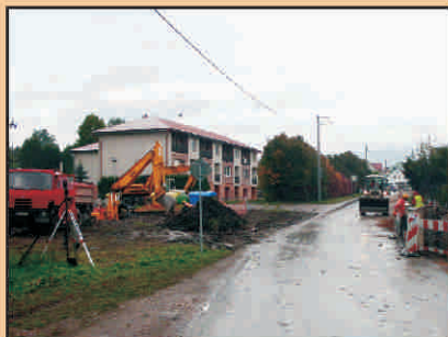
Pokračující práce na kanalizaci.
