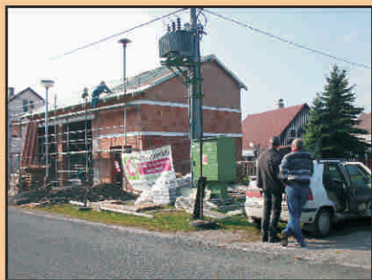
Započaté práce na rekonstrukci hasičárny v Horním Lánově.
