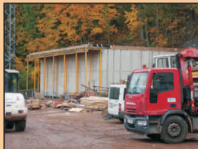
Stavba nové ČOV pod školní jídelnou.
