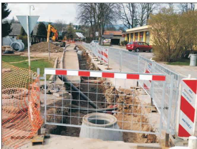
Kanalizace před potravinami.
