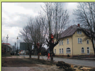
Obnova zeleně před Obecním úřadem.
