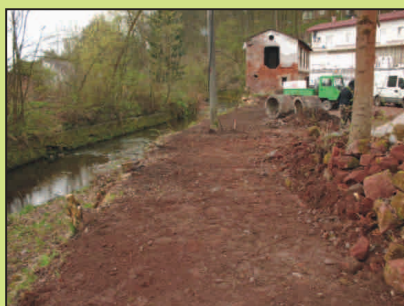
Úprava pozemku u budoucí ČOV Lánov.
