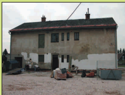
Práce na izolacích a následném zateplení domu čp. 51.
