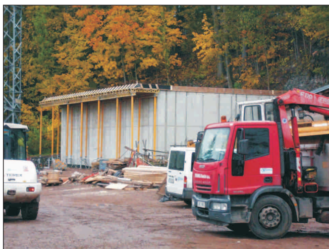
Stavba nové ČOV pod školní jídelnou.
