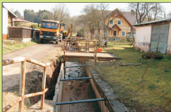
Oprava vodoteče v Dolním Lánově.
