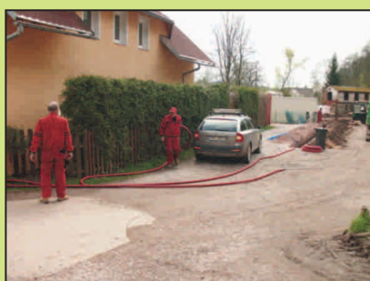
Práce na kabeláži pro budoucí sídlo Vodárenské společnosti.
