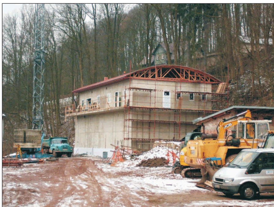
Pokračující stavba ČOV.
