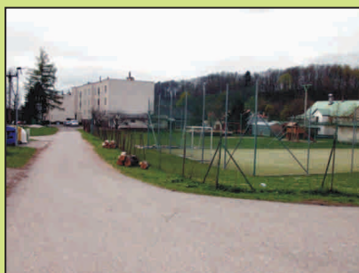
Příprava pro zbudování chodníku u ZŠ.
