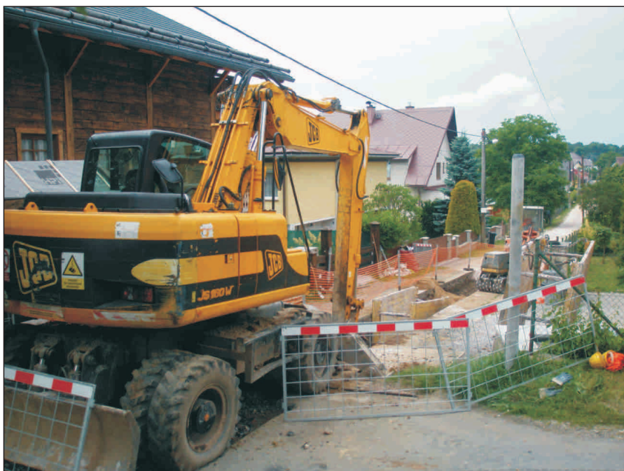
Kanalizace v ulici k ozdravovně.
