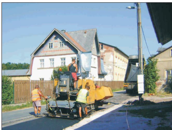
Pokládání asfaltového povrchu v úseku od školy ke kruhovému objezdu..
