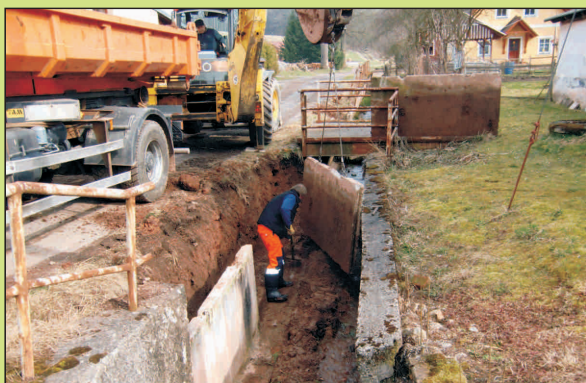
Oprava vodoteče v Dolním Lánově.
