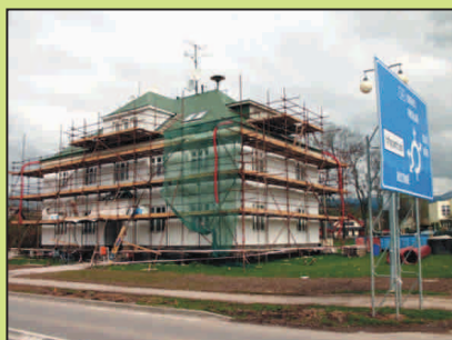
Budova OÚ Lánov - probíhající zateplení.
