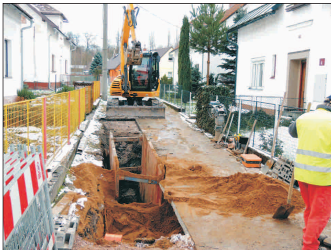
Kanalizace v ulici ke školní jídelně.
