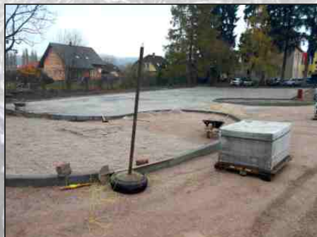
Ze stavby parkoviště u ZŠ.
