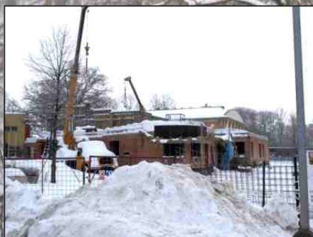
Z průběhu stavby nové školní jídelny.
