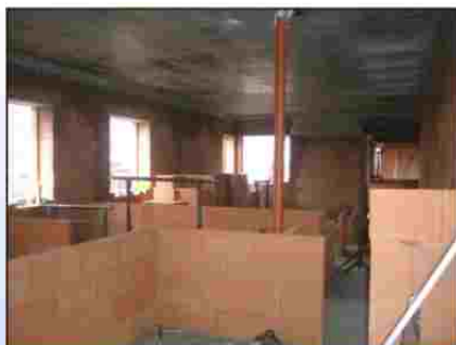
Prostory kuchyně ve výstavbě.
