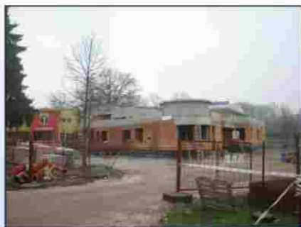
Celkový pohled na novou školní jídelnu.
