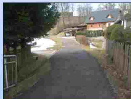
Místní komunikace po opravě.
