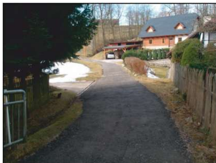
Místní komunikace po opravě.
