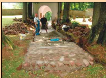
Oprava cesty od brány ke kostelu v Dolním Lánově s použitím původních kamenů.
