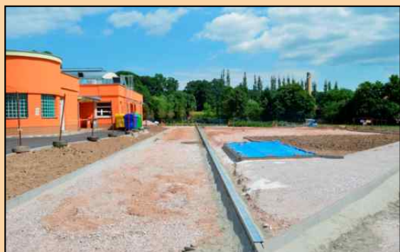
Práce na stavbě sportovního areálu.
