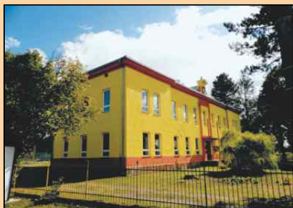
Nová fasáda na ZŠ a MŠ v Dolním Lánově.
