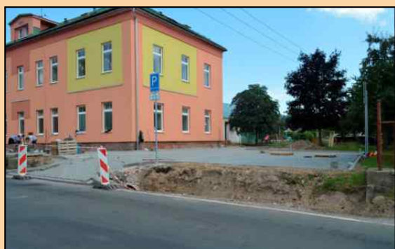
Práce na zámkové dlažbě u budovy „B“ ZŠ Lánov.
