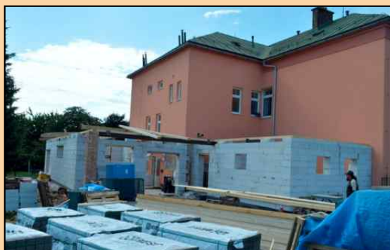
Práce na přístavbě budovy „B“ ZŠ Lánov.
