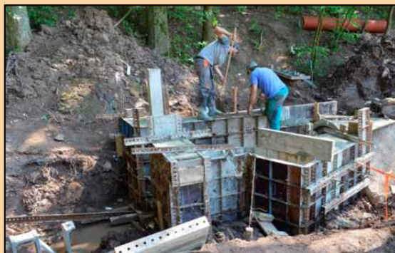
Betonářské práce na obnově malé vodní nádrže na Končinském potoce.
