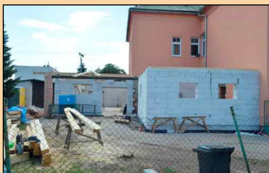
Práce na přístavbě budovy „B“ ZŠ Lánov.
