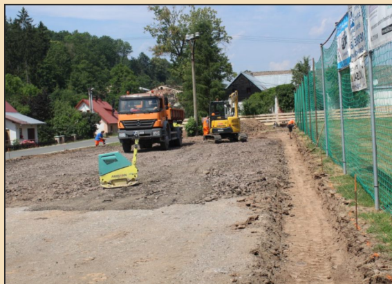
Dolní Lánov - oprava místních komunikací.
