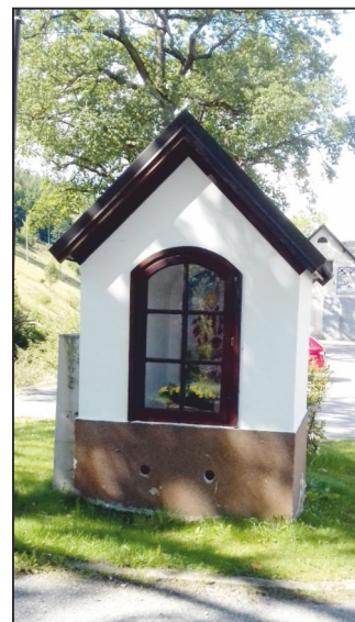
Po opravě. Už zbývá jen sokl.
