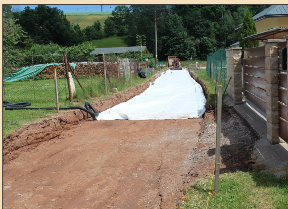
Dolní Lánov - oprava místních komunikací.
