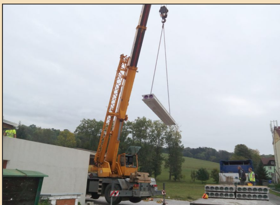
Pokládka panelů na stropy šaten TJ.
