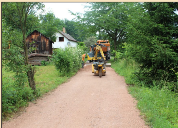
Dolní Lánov - oprava místních komunikací.
