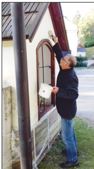
Na začátku letošní renovace.
