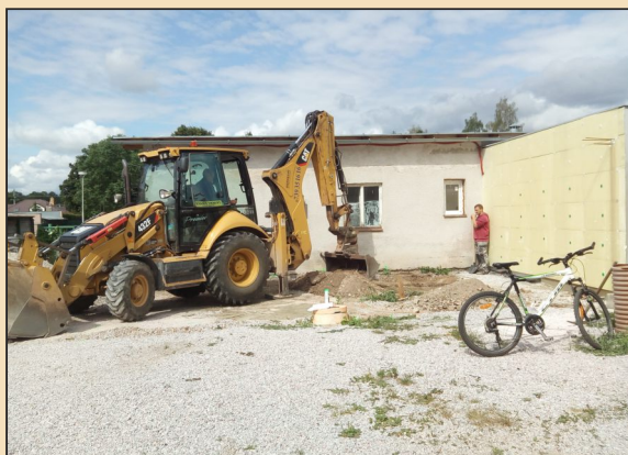
Kopání základů pro šatny TJ.
