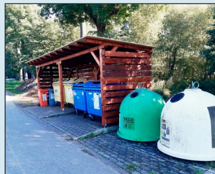
První přístřešek na kontejnery ze začátku října 2021, zhotovený pracovníky TS.
