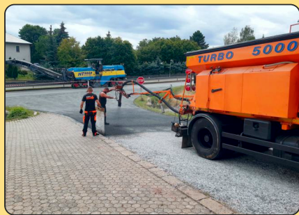
Oprava asfaltu postřikem - cesta za Harmonií.
