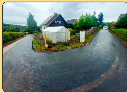
Vyasfaltování cest v lokalitě Seidlov.
