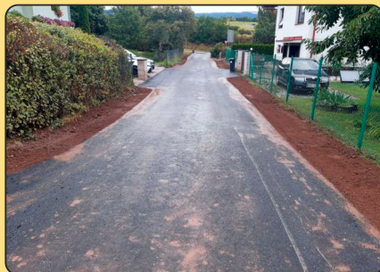
Vyasfaltování cest v lokalitě Seidlov.
