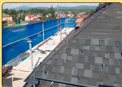
Oprava střechy bývalé fary - areál ZŠ.
