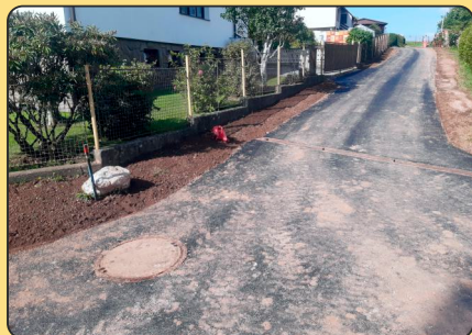
Vyasfaltování cest v lokalitě Seidlov.
