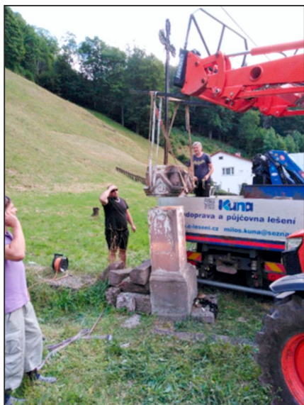
Rozebírání křížku pod penzionem Pajerových.
