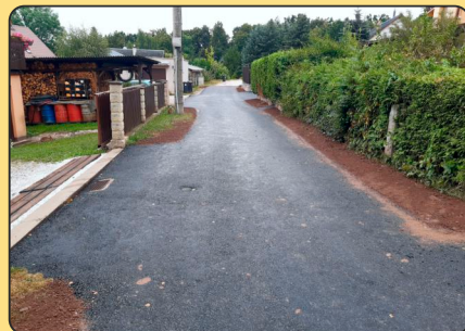
Vyasfaltování cest v lokalitě Seidlov.
