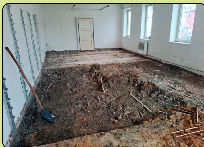
Zahájena rekonstrukce domu čp. 170 v přízemí - vybourání podlah.
