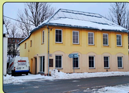
Zahájena rekonstrukce domu čp. 170 v přízemí - provedení hydroizolace svislých stěn metodou injektáže.
