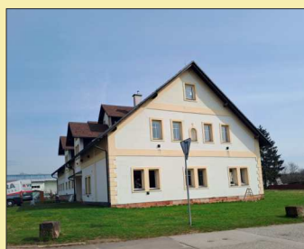
Výměna oken a vchodových dveří v bytovém domě čp. 23 pod Lánovským dvorem.
