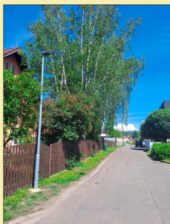
Instalace nových lamp veřejného osvětlení u Lánovského dvora.
