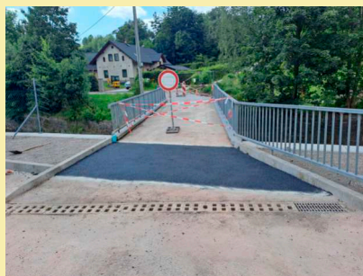
Dokončená rekonstrukce mostu č. 5.
