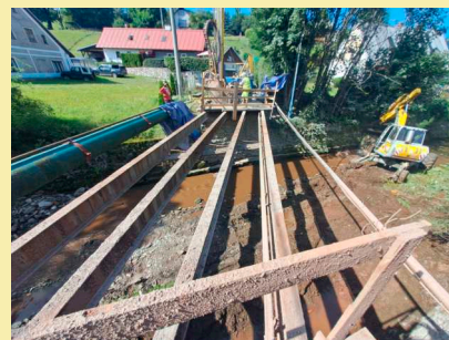
Zahájena rekonstrukce mostu č. 4.
