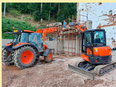
Stavba přístřešku pro komunální techniku.
