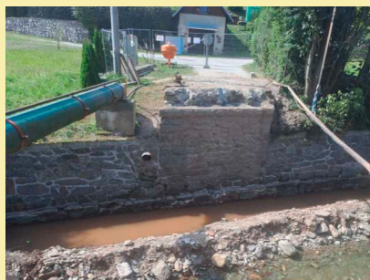
Rekonstrukce mostu č. 4.
