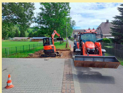
Zpevnění ploch v centru obce.
