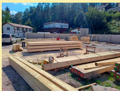
Stavba přístřešku pro komunální techniku.
