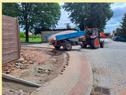
Zpevnění ploch v centru obce.
