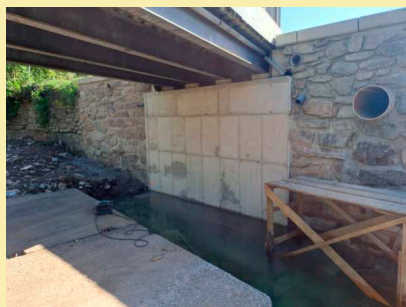
Dokončená rekonstrukce mostu č. 5.
