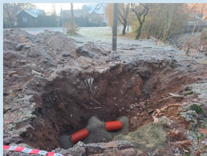
Oprava přerušené dešťové kanalizace v Horním Lánově u Půlpánových.
