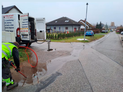
Čištění dešťové kanalizace.
