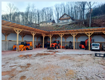
Přístřešek zázemí technických služeb u čp. 100 - probíhající stavba.
