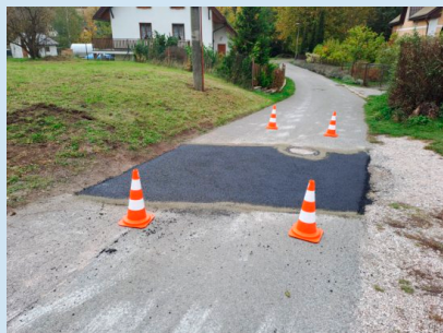
Asfaltování po opravách cest.
