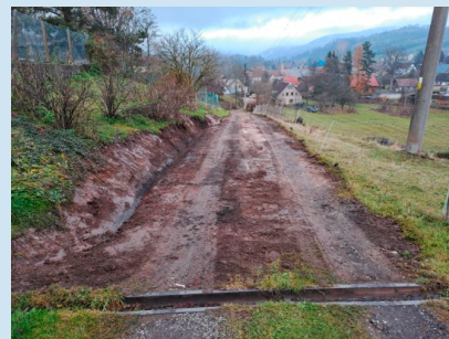
Oprava cesty na Hejdučák ke Tryznovým.
