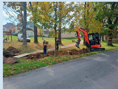
Pokládka optického vedení internetu, KTV + napájení pro altán za prodejnou p. Luksika.
