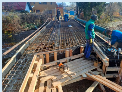
Oprava mostu č. 4.
