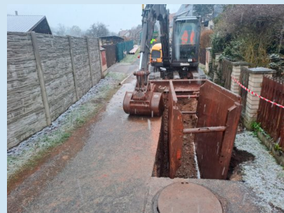
Oprava kanalizace na zadní cestě u Pohořelých.
