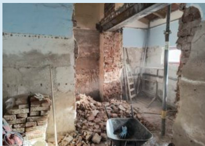
Rekonstrukce umyvárny v MŠ Dolní Lánov.
