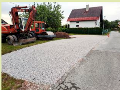
Stavba odstavného parkoviště a odpadového hnízda na Seidlově.
