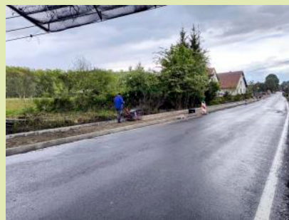
Práce na výstavbě svršku nového chodníku v Dolním Lánově.
