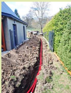
Pokládka optického kabelu internetu + KTV.
