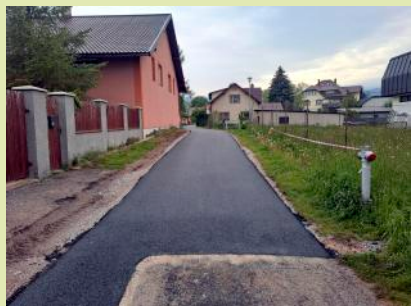
Oprava cesty od zdr. střediska k Lánovskému dvoru + pokládka optického internetu a KTV.
