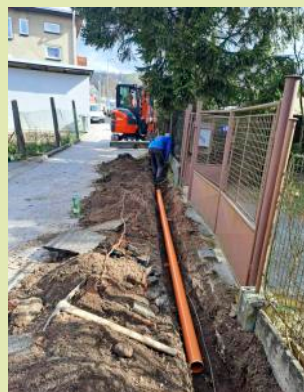
Pokládka optického kabelu internetu + KTV.
