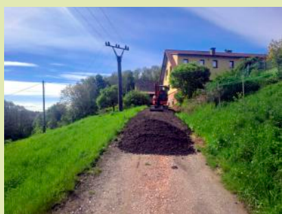
Rekonstrukce cesty k Tryznovým.
