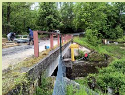
Přípravné práce rekonstrukce mostu na Kunčice.
