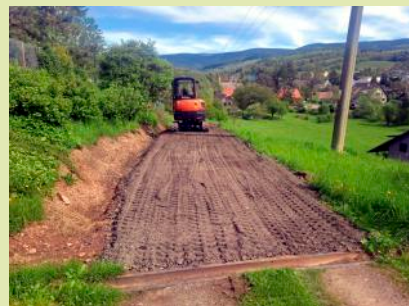
Rekonstrukce cesty k Tryznovým.
