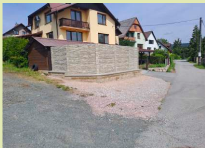
Rozšíření zatáčky do nové stavební lokality Nad roklí.
