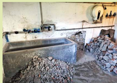
Bourání staré vany ve sklepě OÚ.
