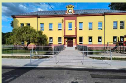
Nově zbudovaný přístup k ZŠ v Dolním Lánově.
