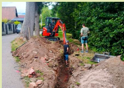
Oprava poruchy KTV v Horním Lánově.
