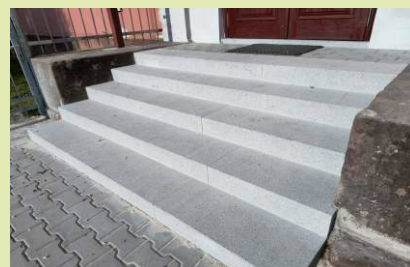
Nové žulové schody u vstupu do ZŠ.
