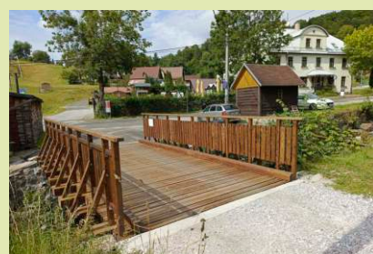
Nový most přes Kotelský potok v Dolním Dvoře.
