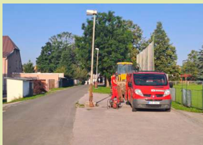
Demontáž lampy VO před hřištěm.
