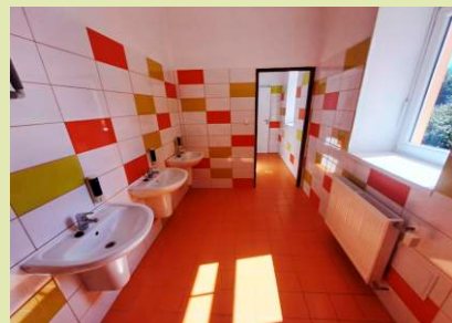
Rekonstrukce umývárek MŠ-B.
