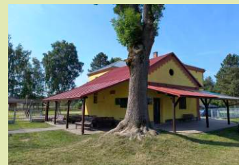
Nově natřené střechy na technické budově u ZŠ v Dolním Lánově.
