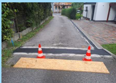
Opravy cest asfalty.
