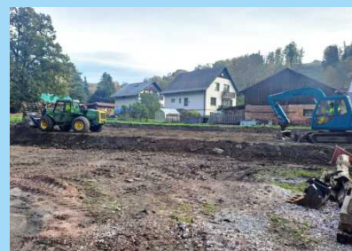
Budování zahrádek na pozemku č.246/1.
