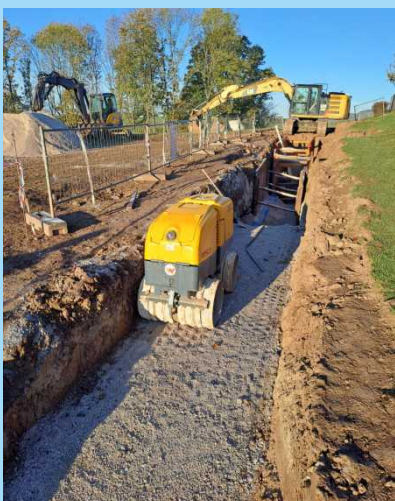
Výstavba nové lokality A1 Nad roklí.
