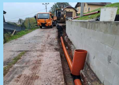
Oprava panelové zadní cesty za mostem č.5.
