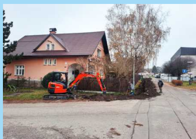
Pokládka optické sítě.
