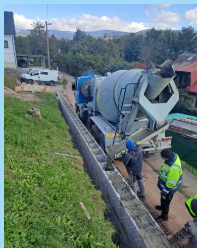
Stavba opěrné zdi na zadní cestě za mostem č.5.
