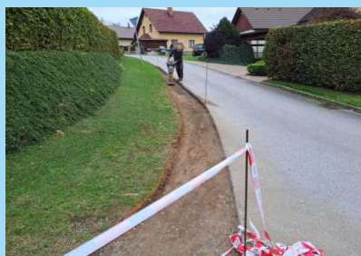
Opravy cest asfalty.
