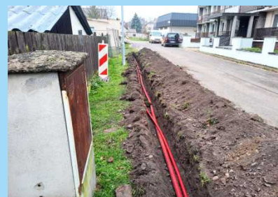
Pokládka optické sítě.
