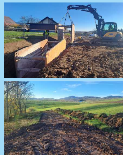
Výstavba nové lokality A1 Nad roklí.
