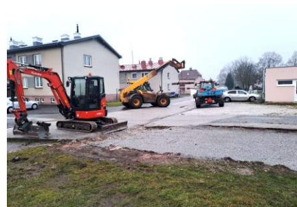
Zpevněná plocha pod kontejner u hřiště.
