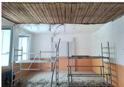
Opravy vyplavené bývalé fary.
