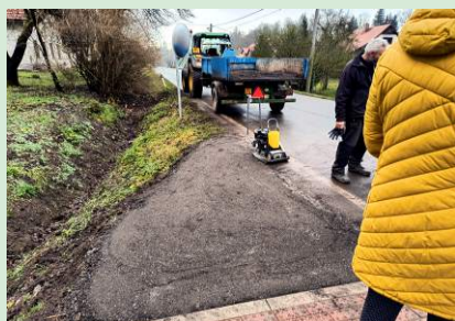
Úprava zakončení chodníku v Dolním Lánově.
