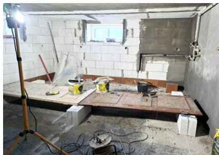
Rekonstrukce sklepa na OÚ.
