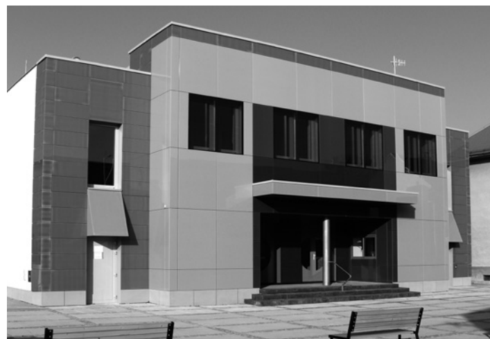
Po rekonstrukci v roce 2015 Fotografie pocházejí z archivu Libora Koldinského
