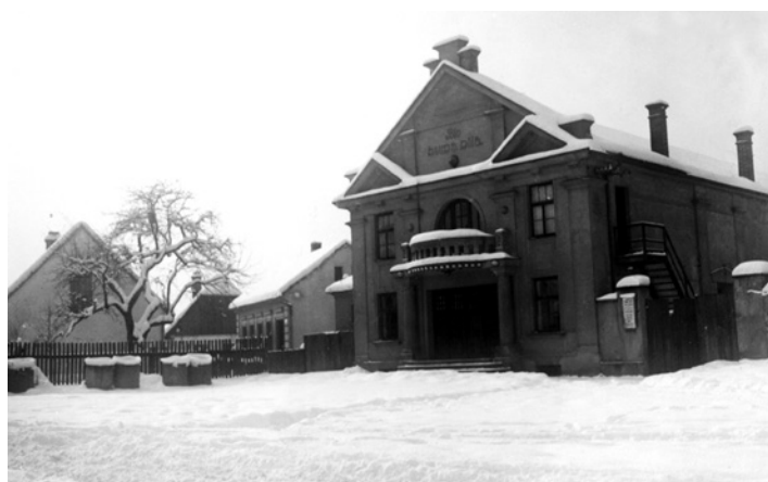
Budova divadla 1922 - ještě není vzadu jeviště, to bylo až 1930
