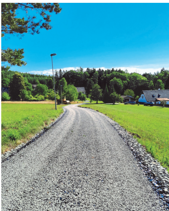
Rekonstrukce komunikace na Souvratí k č.p. 150
