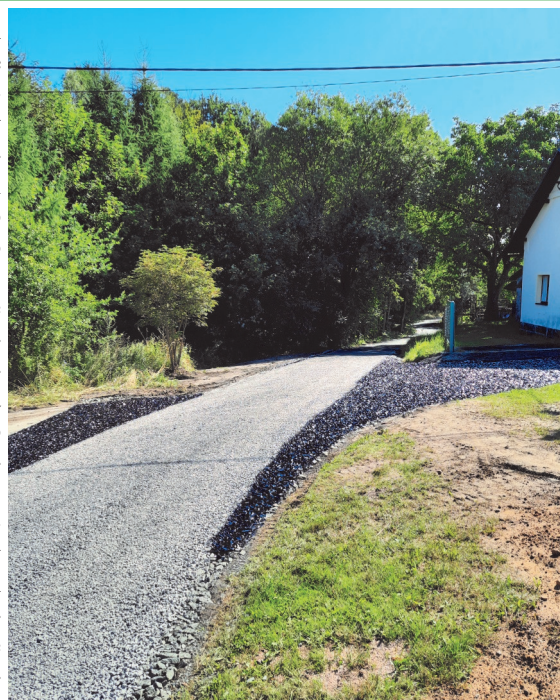
Upravená křižovatka u č.p. 155 Souvratí
