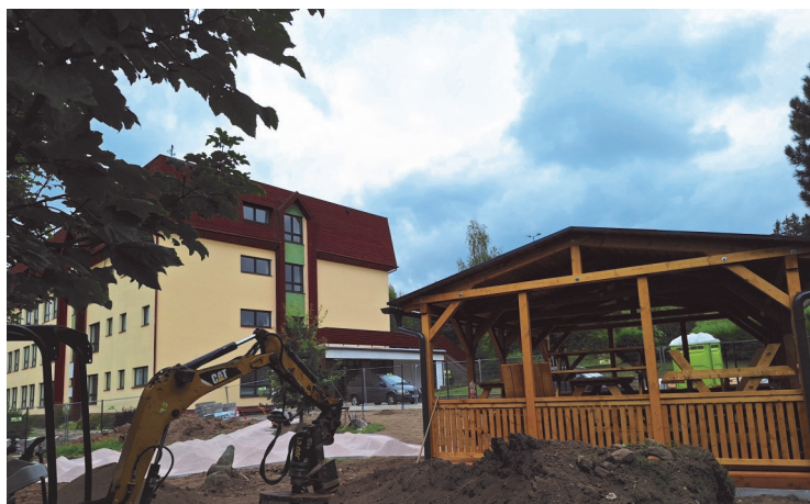
Výstavba venkovní učebny u budovy základní školy.
